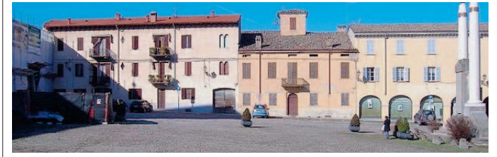
Casa Gombi Sarà ristrutturata e ospiterà residenze per anziani.
